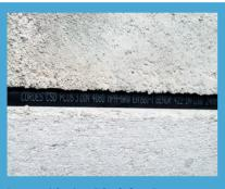
Innenansicht einer Schachtfuge (Lastausgleich) nach Montage (CSD Plus 3)
