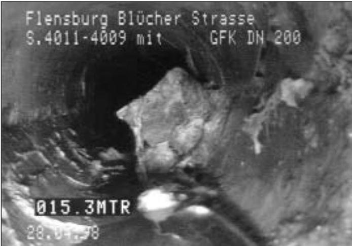
Abbildung 2: Unvollständige Aushärtung eines Schlauchliners
