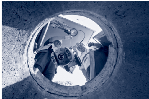
Die Ausstattung eines Unternehmens und die Qualifikation der Mitarbeiter tragen entscheidend zum Erfolg einer Baumaßnahme bei.
