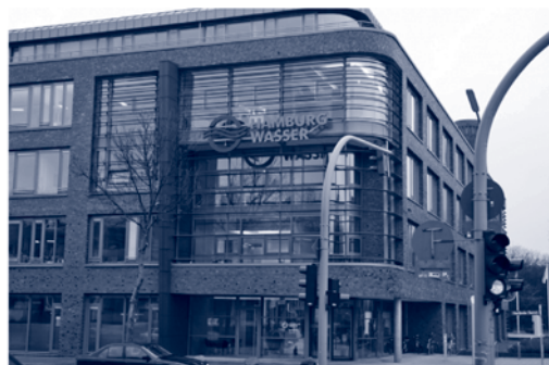
HAMBURG WASSER ist das größte kommunale Trinkwasserversorgungs- und Abwasserbeseitigungsunternehmen Deutschlands.
