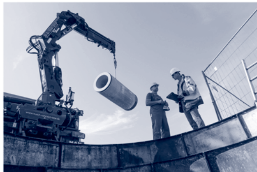
In vorgegebenen Abständen besucht der Prüfsingenieur die Baustellen der Gütezeichen führenden Unternehmen.
