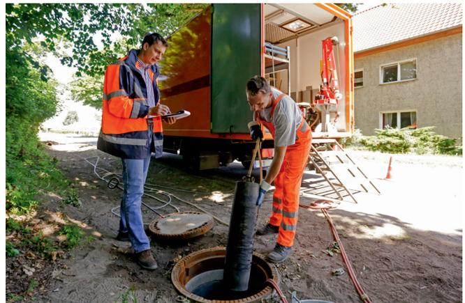
*Im Rahmen der Baustellen- und Firmenbesuche bewerten die Prüflingenieure der Gütegemeinschaft Kanalbau die unterschiedlichen Arbeits- und Verfahrensweisen der Gütezeicheninhaber bei der Dichtheitsprüfung von Einzelrohrverbindungen sowie deren Dokumentation.*
