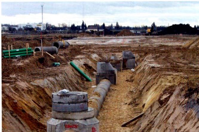
Typische Baustellensituation mit Verlegung von Regenwasser- und Schmutzwasserkanal
