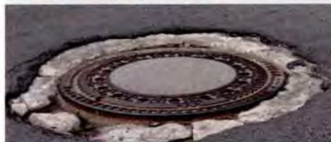
BILD 2: Typische Mängel bei eingebauten Schachtabdeckungen
