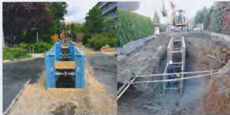
Fachgerecht (1.) und unsachgemäß (2.). Ein nicht fachgerecht eingestellter Verbau hat Einfluss auf das Gleichgewicht des umliegenden Erdreiches und kann zum Beispiel zu Setzungen führen, welche die angrenzende Bebauung erheblich schädigen kann. Foto: Güteschutz Kanalbau
