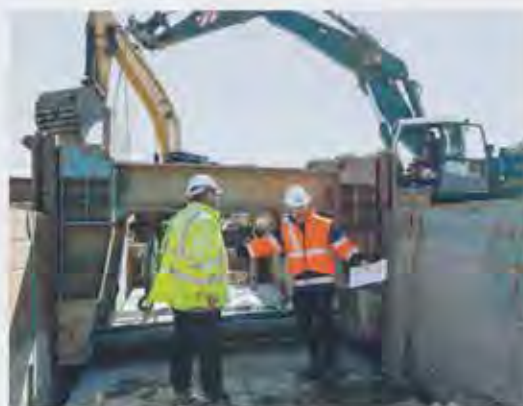
Die Qualifikation des Personals trägt zur Sicherheit auf den Baustellen bei und führt zur geforderten Ausführungsqualität. Foto: GÜTESCHUTZ Kanalbau
