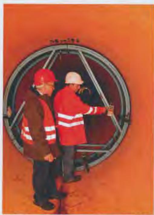
Ist alles dicht? Undichte Kanäle belasten die Umwelt und können teure Folgeschäden nach sich ziehen. Foto: Güteschutz Kanalbau
