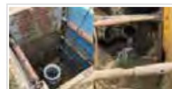
Abb. 2: Fachgerecht (l.) und unsachgemäß (r.): Keine Bagatelle – wer unbefugt ein Gewässer verunreinigt oder sonst dessen Eigenschaften nachteilig verändert, kommt mit dem Gesetz in Konflikt. [Quelle: Güteschutz Kanalbau]
