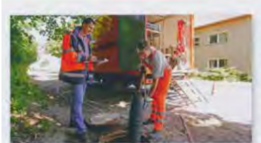
8 Prüflingenieure der Gütegemeinschaft Kanalbau bewerten die Arbeitsweisen der Gütezeicheninhaber
