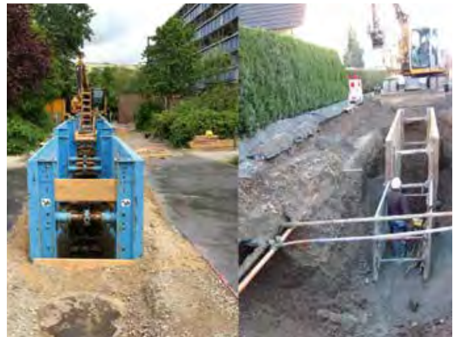
Abb. 1: Fachgerecht (l.) und unsachgemäß (r.): Nicht fachgerecht eingestellter Verbau hat Einfluss auf das Gleichgewicht des umliegenden Erdreiches und kann zum Beispiel zu Setzungen führen, welche die angrenzende Bebauung erheblich schädigen kann.
