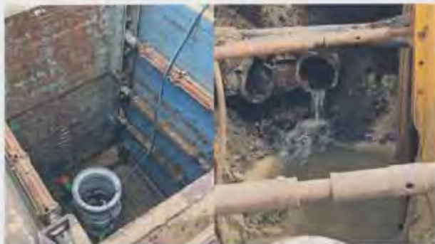
Fachgerecht (l.) und unsachgemäß (r.): Keine Bagatelle - wer unbefugt ein Gewässer verunreinigt oder sonst dessen Eigenschaften nachteilig verändert, kommt mit dem Gesetz in Konflikt.
