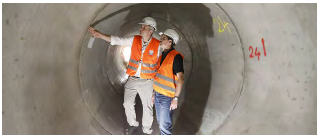
Dieter Walter, Güteschutz Kanalbau und Markus Brüderer, Bauleiter Scharnagl Hoch- und Tiefbau GmbH inspizieren den verlegten ersten Abschnitt des Stauraumkanals. Foto: Güteschutz Kanalbau
