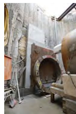
Die Ausbildung des Widerlagers für den zweiten Vortrieb musste so ausgebildet
