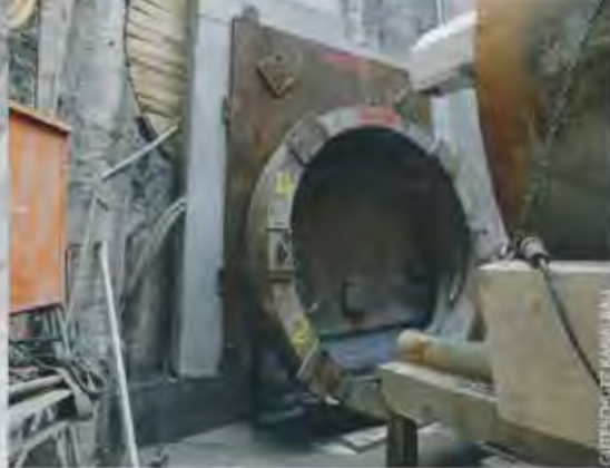
Die Ausbildung des Widerlagers für den zweiten Vortrieb musste so gestaltet werden, dass die Rohre des bereits fertiggestellten ersten Abschnittes nicht beschädigt werden.
