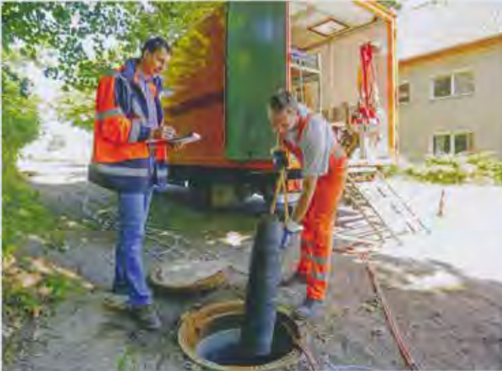
Im Rahmen der Baustellen- und Firmenbesuche bewerten die Prüflingenieur der Gütegemeinschaft Kanalbau die unterschiedlichen Arbeits- und Verfahrensweisen der Gewährleistenden bei der Dichtheitsprüfung von Einzelrohrverbindungen sowie deren Dokumentation. | Foto: Güteschutz Kanalbau
