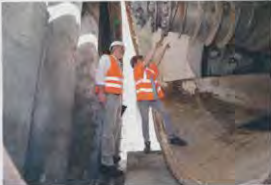
Miriam Liß inspiziert mit Dieter Walter die Abbauwerkzeuge der Vortriebsmaschine.
