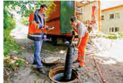
Im Rahmen der Baustellen- und Firmenbesuche bewerten die Prüfingenieure der Gütegemeinschaft Kanalbau die unterschiedlichen Arbeits- und Verfahrensweisen der Gütezeichenhhaber bei der Dichtheitsprüfung von Einzelrohrverbindungen sowie deren Dokumentation. Bild: Güteschutz Kanalbau
