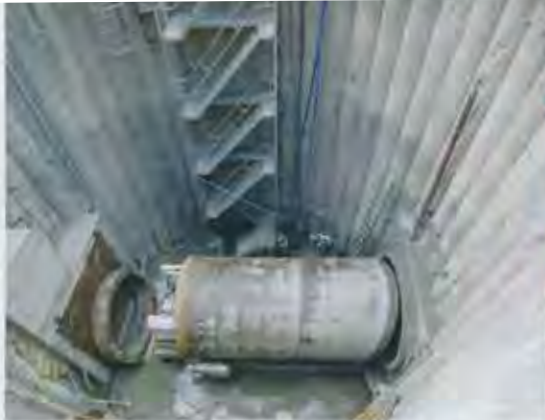
Das Widerlager in der Doppelstärkbaugrube ist für den zweiten Vortrieb errichtet und die Vortriebsmaschine ausgerichtet.
