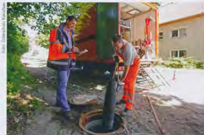
Bild 1: Im Rahmen der Baustellen- und Firmenbesuche bewerten die Prüflingenieure der Gütegemeinschaft Kanalbau die unterschiedlichen Arbeits- und Verfahrenswesen der Gütezeicheninhaber bei der Dichtheitsprüfung von Einzelrohrverbindungen sowie deren Dokumentation
