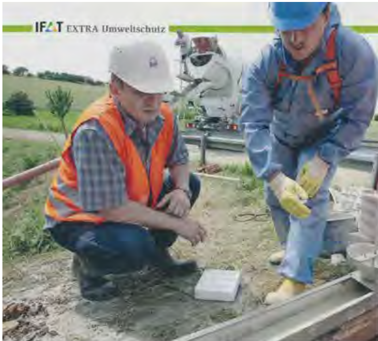
Baustelle: Im Rahmen unangemeldeter Besuche begutachten die Prüfm Ingenieure des Güteschutz Kanalbau die Qualifikation und Zuverlässigkeit der Fachunternehmer.
