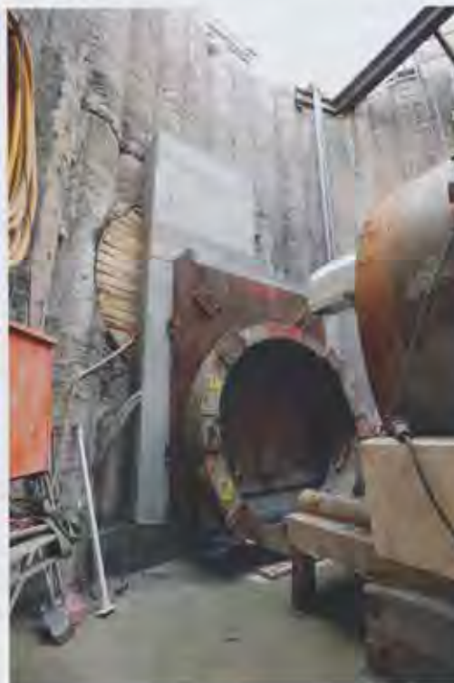
Die Ausbildung des Widerlagers für den zweiten Vortrieb musste so ausgebildet werden, dass die Rohre des bereits fertiggestellten ersten Abschnittes nicht beschädigt werden. Foto: Güteschutz Kanalbau
