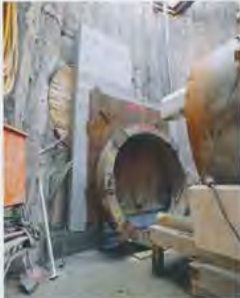
Die Ausbildung des Widerlagers für den zweiten Vortrieb musste so ausgebildet werden, dass die Röhre des bereits fertiggestellten ersten Abschnittes nicht beschädigt werden.
