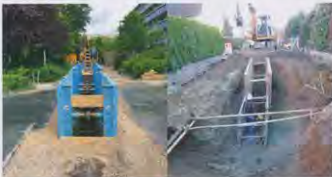
Bild 1: Fachgerecht (l.) und unsachgemäß (r.). Ein nicht fachgerecht eingestellter Verbau hat Einfluss auf das Gleichgewicht des umliegenden Erdreiches und kann z. B. zu Setzungen führen, die die angrenzende Bebauung erheblich schädigen können.
