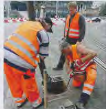
In den Güte- und Prüfbestimmungen RAL-GZ 961 sind die Anforderungen an das Unternehmen definiert. Das für die Feststellung des Istzustandes eingesetzte Personal muss unter anderem baubetriebs- und materialtechnisches Fachwissen aus dem Kanalbau besitzen (Güte- und Prüfbestimmungen, April 2016).
