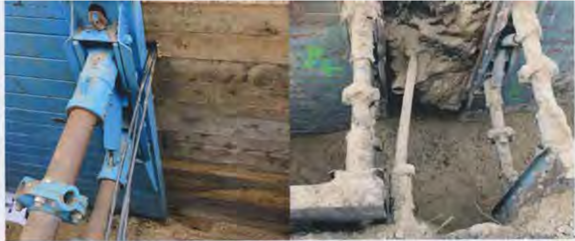
Fachgerecht (l.) und unsachgemäß (r.); Aussparungen im Verbausystem sind grundsätzlich nicht zulässig – die Verkleidung muss vollständig sein. Foto: Güteschutz Kanalbau
