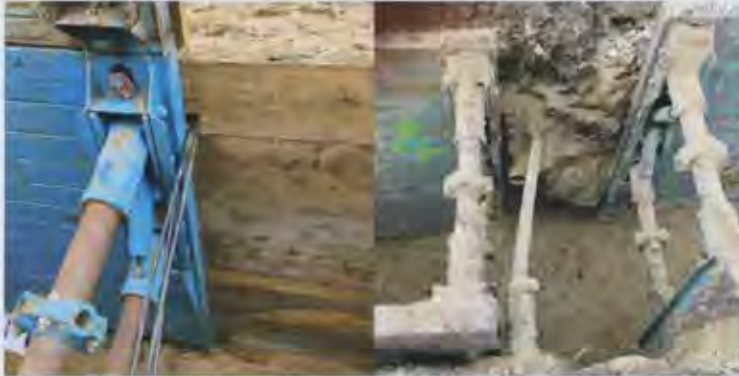
Abb. 3: Fachgerecht (I.) und unsachgemäß (II.): Aussparungen im Verbausystem sind grundsätzlich nicht zulässig – die Verkleidung muss vollständig sein.
