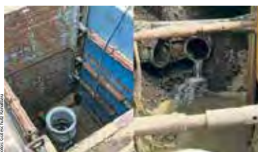
Abb. 2: Fachgerecht (l) und unsachgemäß (r): Keine Bagatelle – wer unbefugt ein Gewässer verunreinigt oder sonst dessen Eigenschaften nachteilig verändert, kommt mit dem Gesetz in Konflikt.
