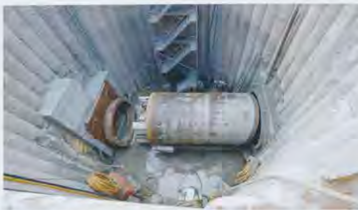
Das Wägelager in der Doppelsartbaugrube ist für den zweiten Vortrieb errichtet und die Vortriebsmaschine ausgerichtet.
