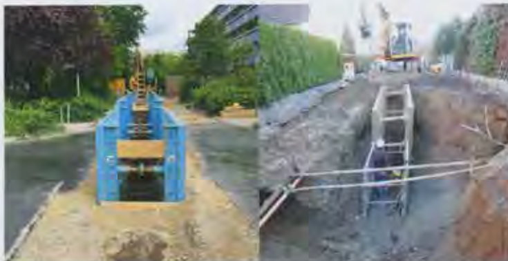
Abb. 1: Fachgerecht (l.) und unsachgemäß (r.): Ein nicht fachgerecht eingestellter Verbau hat Einfluss auf das Gleichgewicht des umliegenden Erdreiches und kann zum Beispiel zu Setzungen führen, welche die angrenzende Bebauung erheblich schädigen kann.
