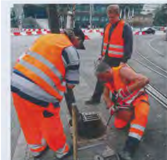
In den Güte- und Prüfbestimmungen RAL-GZ 961 sind die Anforderungen an das Unternehmen definiert. Das für die Feststellung des Istzustandes eingesetzte Personal muss unter anderem bau-, betriebs- und materialtechnisches Fachwissen aus dem Kanalbau besitzen (Güte- und Prüfbestimmungen, April 2016).
