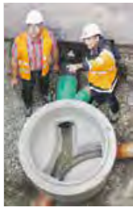
Der Prüfingenieur besucht die Baustelle. Bild: Güteschutz Kanalbau
