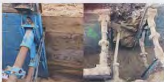
Bild 3. Fachgerecht (l.) und unsachgemäß (r.). Aussparungen im Verbausystem sind grundsätzlich nicht zulässig – die Verkleidung muss vollflächig sein
