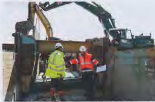
Die Qualifikation des Personals trägt zur Sicherheit auf den Baustellen bei und führt zur geforderten Ausführungsqualität.
