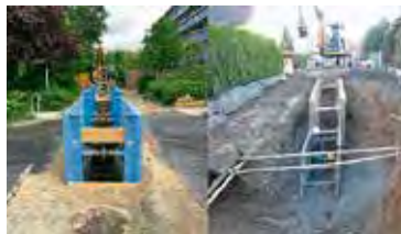
Abb. 1: Fachgerecht (l) und unsachgemäß (r): Ein nicht fachgerecht eingestellter Verbau hat Einfluss auf das Gleichgewicht des umliegenden Erdreiches und kann zum Beispiel zu Setzungen führen, welche die angrenzende Bebauung erheblich schädigen kann.
