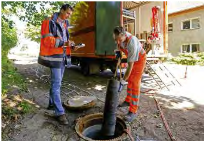
Abb. 4: Im Rahmen der Baustellen- und Firmenbesuche bewerten die Prüfm Ingenieure der Gütegemeinschaft Kanalbau die unterschiedlichen Arbeits- und Verfahrensweisen der Gütezeicheninhaber bei der Dichtheitsprüfung von Einzelrohrverbindungen sowie deren Dokumentation (Foto: Güteschutz Kanalbau)
