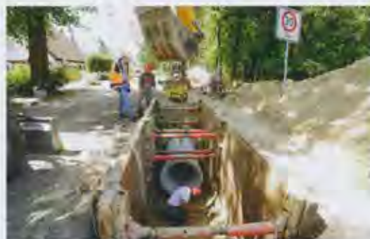
Bild 3. Das Zusammenwirken von Rörtung, Bauteil und Verfüllung ist Grundlage für die Stand- und Betriebssicherheit von Rohrleitungen (Grafiken: Foto, Tabellen, Göttschütz Kanalbau)
