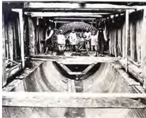
1872 entstand das Geest-Stammsiel, das noch heute zu den Hauptschlagadern des Hamburger Kanalnetzes zählt.
