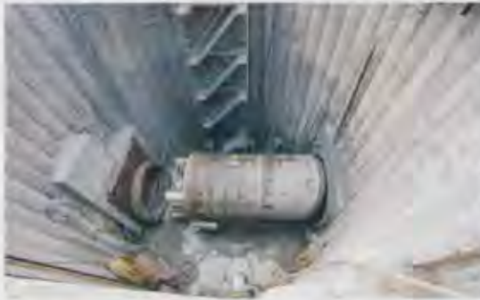
Quelle: Güteschutz Kanalbau
