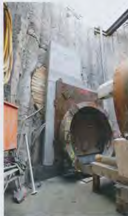
Das Widerlager für den zweiten Vortrieb musste so ausgebildet werden, dass die Rohre des bereits fertiggestellten ersten Abschnittes nicht beschädigt wurden.
