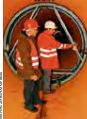
Ist alles dicht? Undichte Kanäle belasten die Umwelt und können teure Folgeschäden nach sich ziehen.
