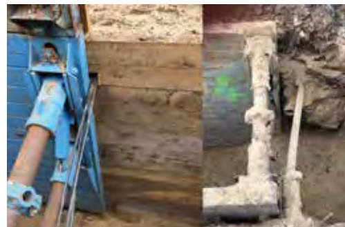
Abb. 3: Fachgerecht (l.) und unsachgemäß (r.): Aussparungen im Verbausystem sind grundsätzlich nicht zulässig – die Verkleidung muss vollflächig sein.
