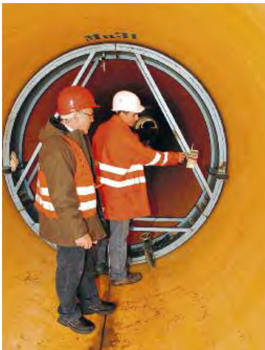
Abb. 1: Ist alles dicht? Undichte Kanäle belasten die Umwelt und können teure Folgeschäden nach sich ziehen (Foto: Güteschutz Kanalbau)
