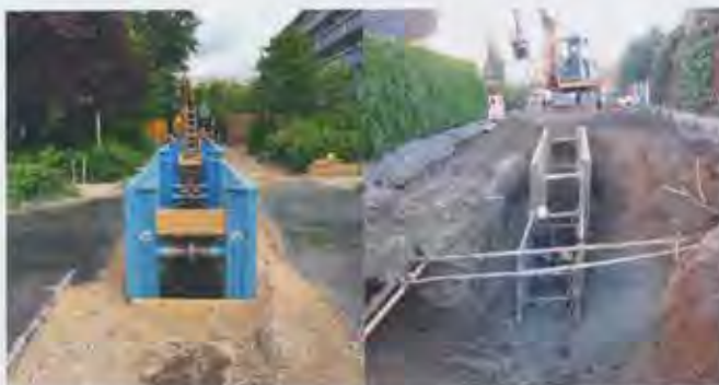
Bild 1: Fachgerecht (l.) und ursachengemäß (r.). Ein nicht fachgerecht eingestellter Verbau hat Einfluss auf das Gleichgewicht des umliegenden Erdreiches und kann z. B. zu Setzungen führen, die die angrenzende Bebauung erheblich schädigen können
