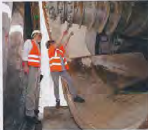
Bild 3: Miriam Liß inspiziert mit Dieter Walter die Abbaugeräte der Vortriebsmaschine
