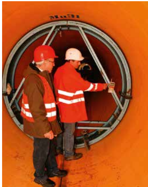
Ist alles dicht? Undichte Kanäle belasten die Umwelt und können teure Folgeschäden nach sich ziehen.
