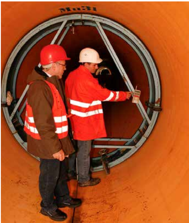
Bild 1: Ist alles dicht? Undichte Kanäle belasten die Umwelt und können teure Folgeschäden nach sich ziehen
