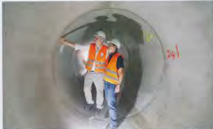
Dieter Walter und Markus Bröderer inspizieren den verlegten ersten Abschnitt des Stauraumkanals.
