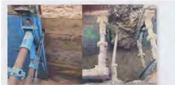
18. Fachgerechte Baustellenabsicherung – Was man beachten sollte!
