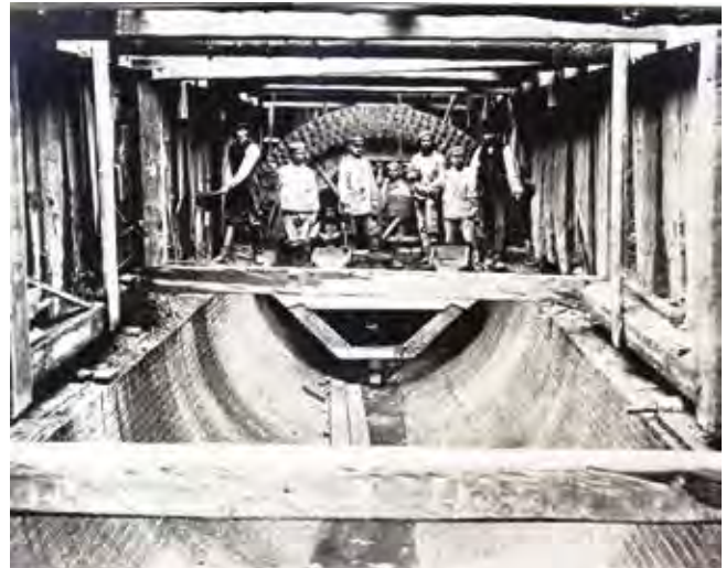
1872 entstand das Geest-Stammsiel, das noch heute zu den Hauptschlagadern des Hamburger Kanalnetzes zählt.
