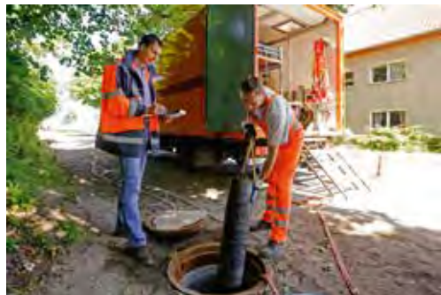
Im Rahmen der Baustellen- und Firmenbesuche bewerten die Prüflingenieure der Gütegemeinschaft Kanalbau die unterschiedlichen Arbeits- und Verfahrensweisen der Gütezeicheninhaber bei der Dichtheitsprüfung von Einzelrohrverbindungen sowie deren Dokumentation.
