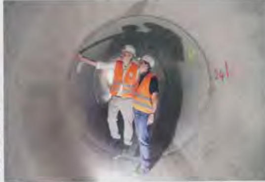
Dieter Walter und Markus Bröderer inspizieren den verlegten ersten Abschnitt des Stauraumkanals.
