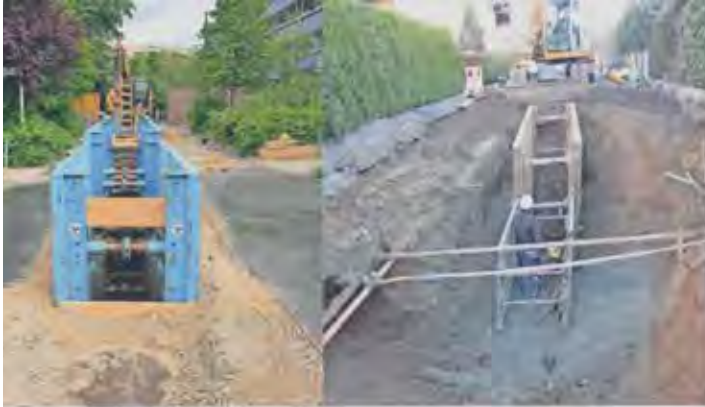
Fachgerecht (l.) und unsachgemäß (r.): Ein nicht fachgerecht eingestellter Verbau hat Einfluss auf das Gleichgewicht des umliegenden Erdreichs und kann zu Setzungen führen, welche die angrenzende Bebauung erheblich schädigen kann. Foto: Güteschutz Kanalbau
