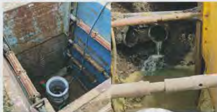
Abb. 2: Fachgerecht (l.) und unsachgemäß (r.): Keine Bagatelle – wer unbefugt ein Gewässer verunreinigt oder sonst dessen Eigenschaften nachteilig verändert, kommt mit dem Gesetz in Konflikt.
