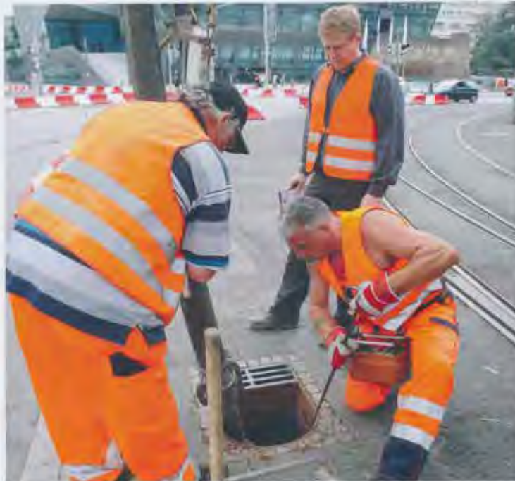
In den Güte- und Prüfbestimmungen RAL-GZ 961 sind die Anforderungen an das Unternehmen definiert. Das für die Feststellung des Istzustandes eingesetzte Personal muss unter anderem bau-, betriebs- und materialtechnisches Fachwissen aus dem Kanalbau besitzen (Güte- und Prüfbestimmungen, April 2016). (Foto: Güteschutz Kanalbau)
