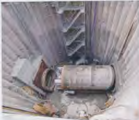
Bild 2: Das Widerlager in der Doppelstartbaugrube ist für den zweiten Vortrieb errichtet und die Vortriebsmaschine ausgerichtet
