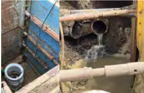
Abb. 2: Fachgerecht (l.) und unsachgemäß (r.): Keine Bagatelle – wer unbefugt ein Gewässer verunreinigt oder sonst dessen Eigenschaften nachteilig verändert, kommt mit dem Gesetz in Konflikt.
