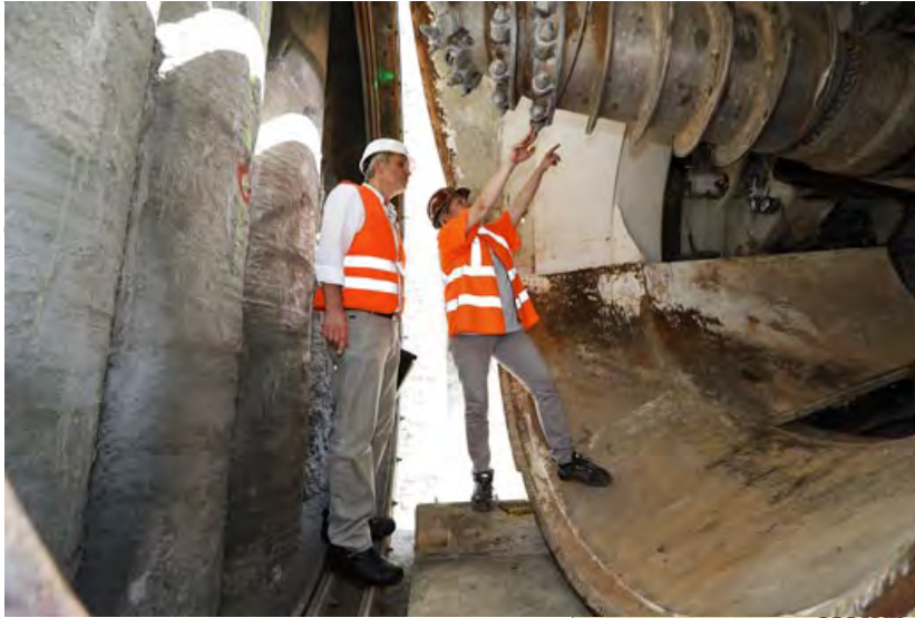
Bild: Güteschutz Kanalbau
