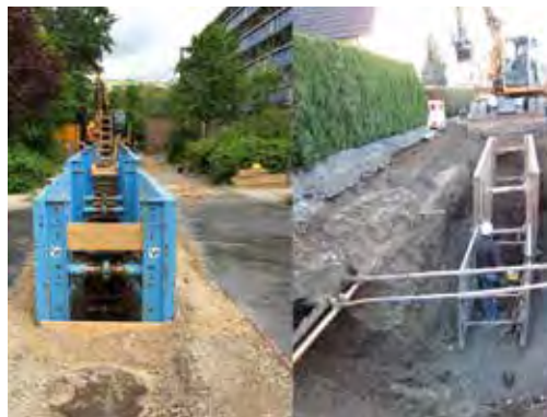
Abb. 1: Fachgerecht (l.) und unsachgemäß (r.): Nicht fachgerecht eingestellter Verbau hat Einfluss auf das Gleichgewicht des umliegenden Erdreiches und kann zum Beispiel zu Setzungen führen, welche die angrenzende Bebauung erheblich schädigen kann.
