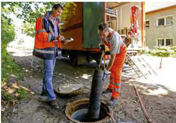
Abb. 4: Im Rahmen der Baustellen- und Firmenbesuche bewerten die Prüffingenieure der Gütegemeinschaft Kanalbau die unterschiedlichen Arbeits- und Verfahrensweisen der Gütezeicheninhaber bei der Dichtheitsprüfung von Einzelrohrverbindungen sowie deren Dokumentation (Foto: Güteschutz Kanalbau)
