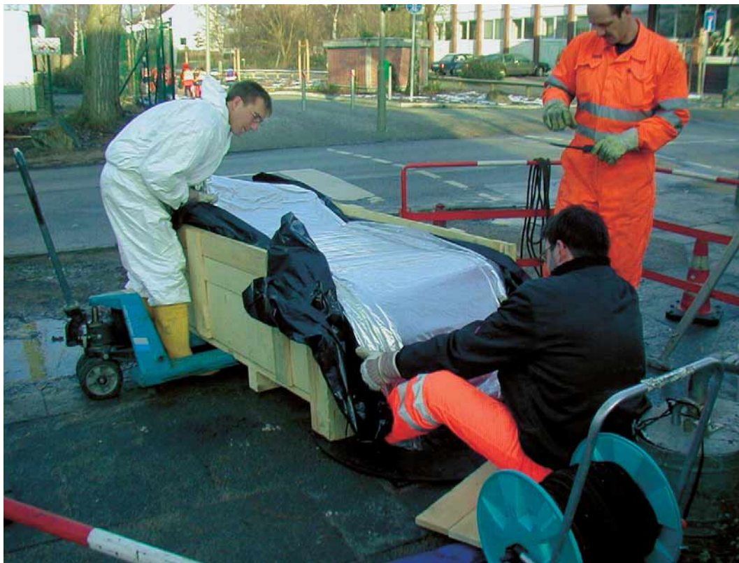
Materialeingangskontrolle beim Schlauchlining mit UV-Licht-Aushärtung.
