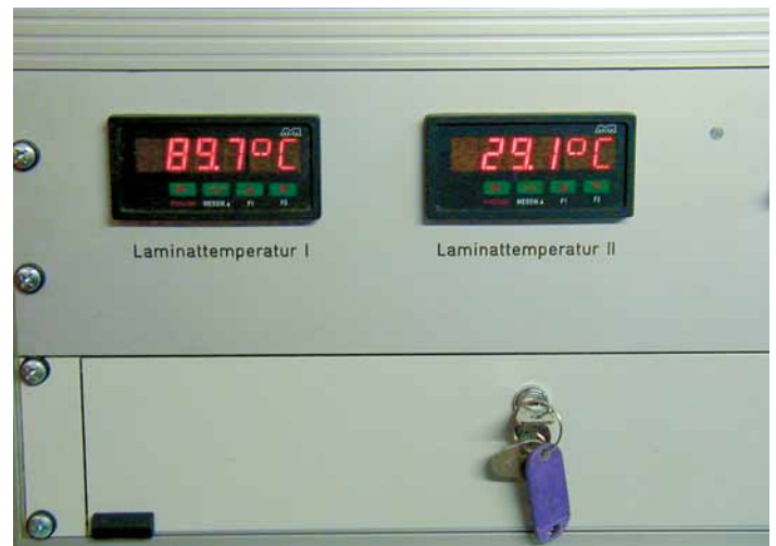
Aufzeichnung der Linertemperaturen beim Einbau des Schlauchliners mit UV-Lichthärtung.
