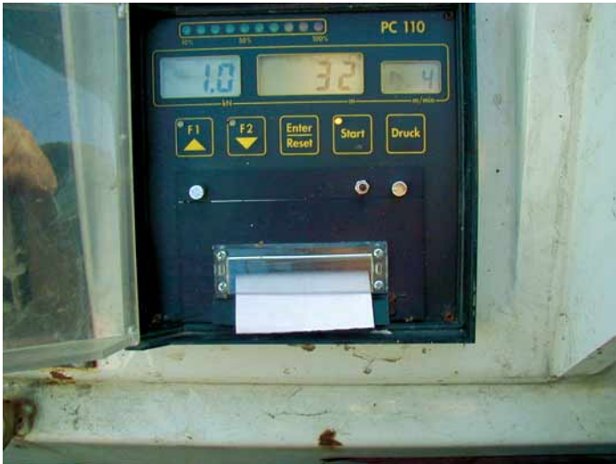
Begrenzung und Aufzeichnung der Zugkräfte beim Einzug des Schlauchliners mit UV-Lichthärtung.
