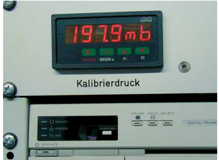
Überwachung und Aufzeichnung des Aufstelldrucks beim Einbau des Schlauchliners mit UV-Lichthärtung.
