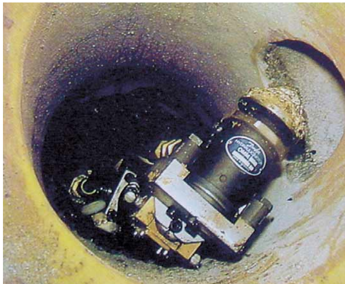
Überwachung der Fräsarbeiten nach Einbau des Schlauchliners unter TV-Beobachtung.
