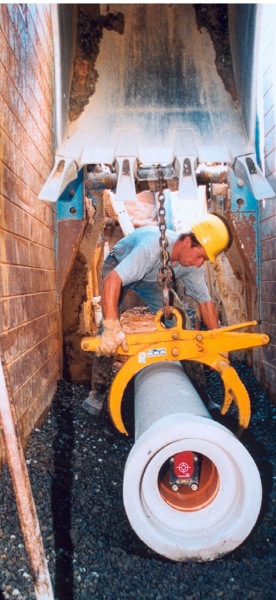
Abb. 1 Permanente Weiterbildung zahlt sich aus: Qualifiziertes Arbeiten ist ein Garant für die nötige Sicherheit auf den Baustellen sowie für eine hochwertige Ausführungsqualität. Das entsprechende Know-how trägt dazu bei, dass Abwasserleitungen und -kanäle fachgerecht und wirtschaftlich erstellt werden und über viele Jahre einwandfrei funktionieren.
