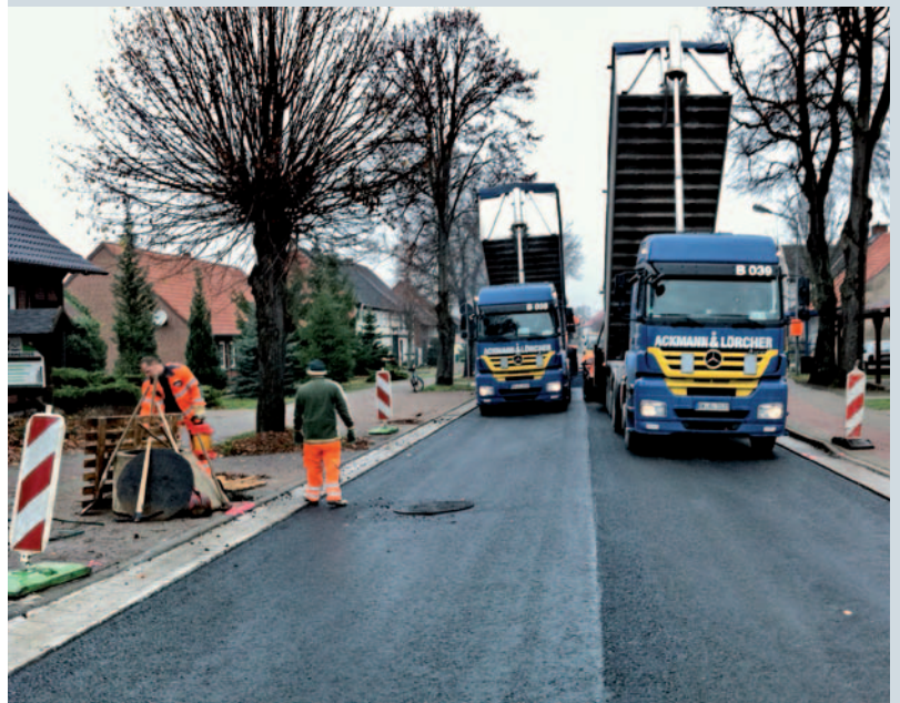
BILD 6: Einbausituation in der Baustellenpraxis
