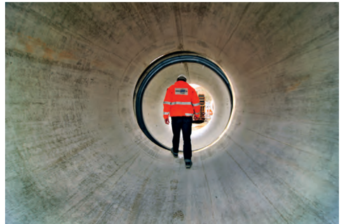
Zur Gütesicherung gehört auch eine Sichtprüfung der 4 m langen Stahlbetonrohre DN 2500 vor dem Einbau der Rohre.
