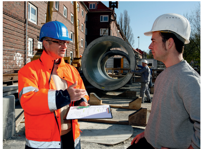
Der Einsatz von Vortriebstechnik erfordert Erfahrung und Sachverstand von allen Beteiligten.
