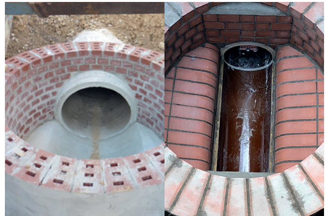
Abb. 3: Unsachgemäß bzw. fachgerecht: Verwendung unzulässiger Klinker (l.). Fachgerecht hergestelltes Schachtunterteil (r.).
