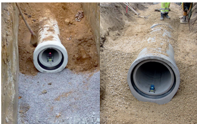
Abb. 2: Unsachgemäß bzw. fachgerecht: Unterschiedliche Materialien für untere und obere Bettungsschicht (l.). Einheitliches Material für die Bettung (r.).
