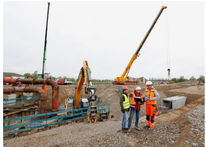
Bei der Baustellenprüfung überzeugt sich Güteschutz-Prüfingenieur Marcus Peterlik (Mitte) zusammen mit Tiefbauamtsleiter Urs Keil (links) und Polier Kai Miethke (rechts) von dem Stand der Bauarbeiten.
