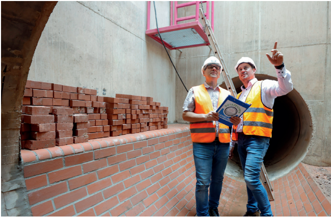
Die Baustelle ist auch ein wichtiger Ort für den fachlichen Dialog der Baupartner.
