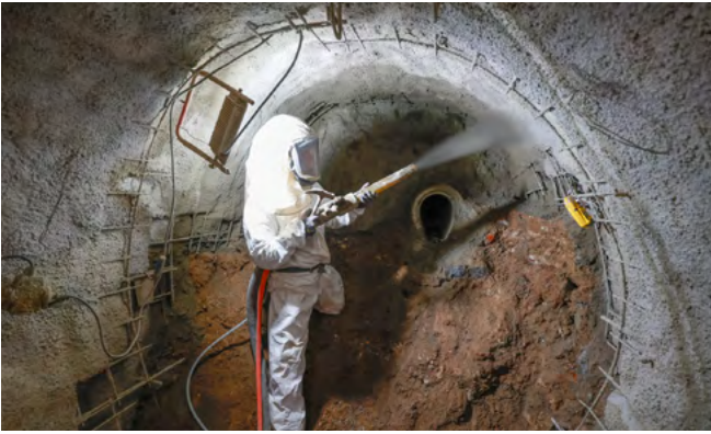
Zur Sicherung des Stollenquerschnitts wird Spritzbeton aufgetragen.
