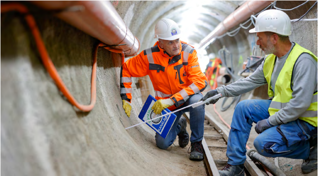
Der neue Leitfaden VB wurde während einer laufenden Baumaßnahme erarbeitet und weiterentwickelt.
