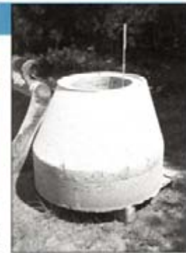
Abbildung 7: Schachthals mit angeformtem Schachtring
