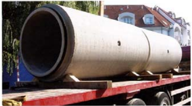
Der fachgerechte Transport der Rohre zur Einbaustelle und eine sorgfältige Kontrolle vor dem Einbau sind wichtige Bausteine der Gütesicherung auf der Baustelle.
