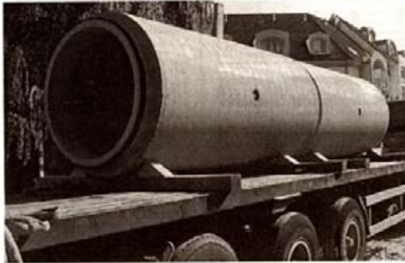
Der fachgerechte Transport der Röhre zur Einbaustelle und eine sorgfältige Kontrolle vor dem Einbau sind wichtige Bausteine der Gütesicherung auf der Baustelle.
