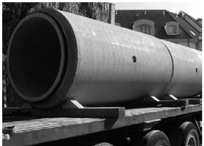
Der fachgerechte Transport der Rohre zur Einbaustelle und eine sorgfältige Kontrolle vor dem Einbau sind wichtige Bausteine der Gütesicherung auf der Baustelle.
