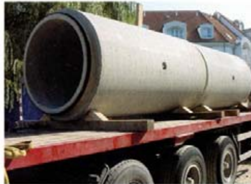
Der fachgerechte Transport der Rohre zur Einbaustelle und eine sorgfältige Kontrolle vor dem Einbau sind wichtige Bausteine der Gütesicherung auf der Baustelle Foto: Güteschutz Kanalbau
