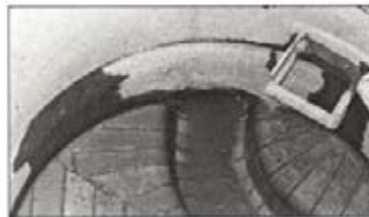
Abbildung 8: Beispiel für das erste Steigmaß bei Steigisen bzw. Steigbügel und einer Abdeckung aus Beton/Guss
