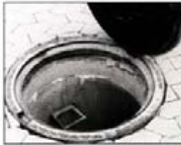
Abbildung 2: Nicht vollständig vermörtelter Auflagerring und fehlerhafter Einbau einer Schachtabdeckung innerhalb einer Verbundsteinpflasterfläche
