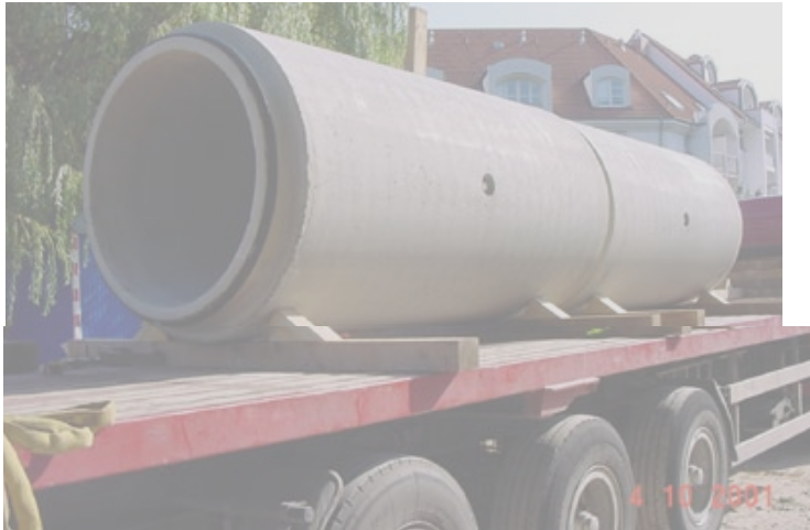
Der fachgerechte Transport der Rohre zur Einbaustelle und eine sorgfältige Kontrolle vor dem Einbau sind wichtige Bausteine der Gütesicherung auf der Baustelle.
