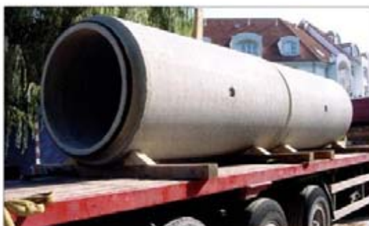
Der fachgerechte Transport der Röhre zur Einbaustelle und eine sorgfältige Kontrolle vor dem Einbau sind wichtige Bausteine der Gütesicherung auf der Baustelle
