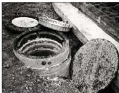
Abbildung 3: Schacht mit korrekt vorbereitetem Höhenausgleich
