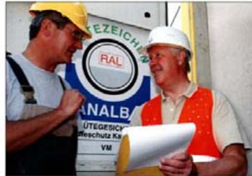
Bild: Ein bewährtes Team für fachgerechten Kanalbau: Ein Prüfingenieur der Gütegemeinschaft (re.) im Gespräch mit einem Kanalbauer.
