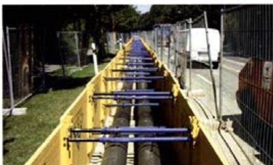
Abb. 2: Kanalbauarbeiten im Schutz eines Stahl-Leichtverbaut
