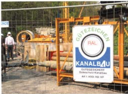
Gütesicherte Tiefbaumaßnahme: Das Baustellenschild weist die Gütezeichen aus, die das beauftragte Unternehmen führen darf.
