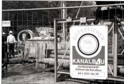
Gütesicherte Tiefbaumaßnahme: Das Baustellenschild weist die Gütezeichen aus, die das beauftragte Unternehmen führen darf.
