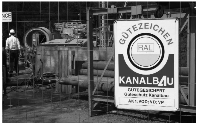
Gütegesicherte Tiefbaumaßnahme: Das Baustellenschild weist die Gütezeichen aus, die das beauftragte Unternehmen führen darf.
