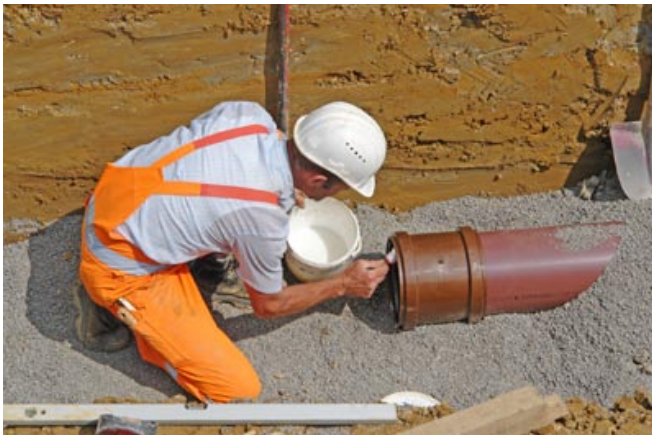
Firmen, die ein Gütezeichen Kanalbau führen, sind der geeignete Partner für den fachgerechten Einbau von Kanalrohren.
