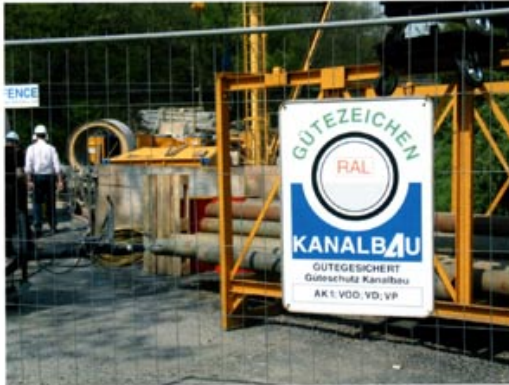
Foto: Gütegesicherte Tiefbaumaßnahme: Das Baustellenschild weist die Gütezeichen aus, die das beauftragte Unternehmen führen darf
