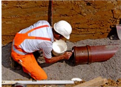
Firmen, die ein Gütezeichen Kanalbau führen, sind der geeignete Partner für den fachgerechten Einbau von Kanalrohren Foto: GüteschutzKanalbau
