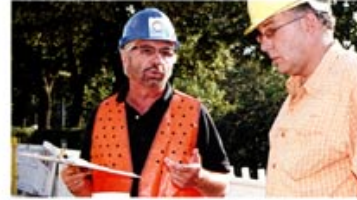
Qualität als Ziel: Ein Auftraggeber im Gespräch mit einem Prüflingenieur der Gütegemeinschaft Kanalbau auf der Baustelle.
