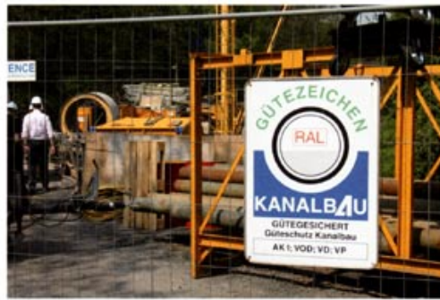
Gütesicherte Tiefbaumaßnahme: Das Baustellenschild weist die Gütezeichen aus, die das beauftragte Unternehmen führen darf Foto: Güteschutz Kanalbau
