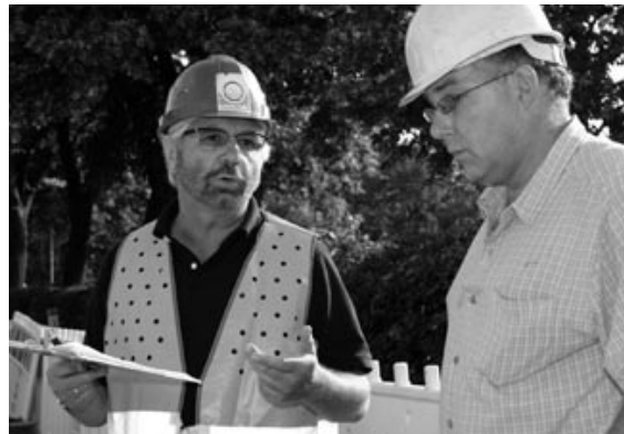
Qualität als Ziel: Ein Auftraggeber im Gespräch mit einem Prüflingen der Gütegemeinschaft Kanalbau auf der Baustelle.
