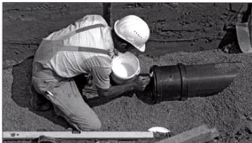
Firmen, die ein Gütezeichen Kanalbau führen, sind der geeignete Partner für den fachgerechten Einbau von Kanalrohren
