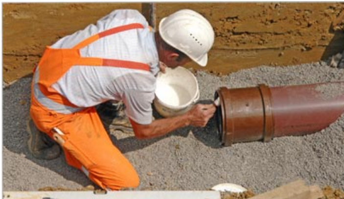
Die Sanierung privater Grundstücksentwässerungsanlagen hat Konjunktur.
