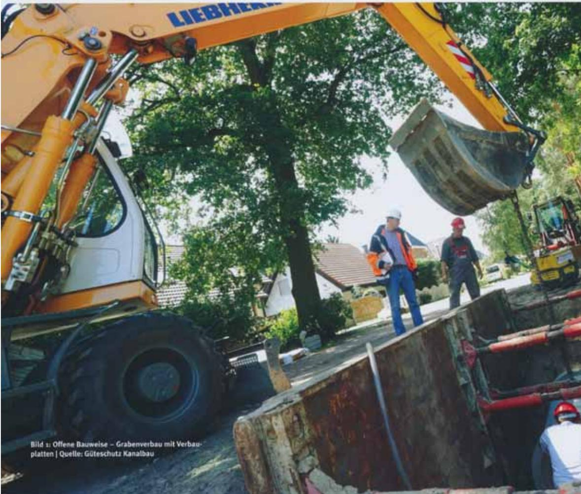
Bild 1: Offene Bauweise – Grabenverbau mit Verbauplatten | Quelle: Güteschutz Kanalbau
