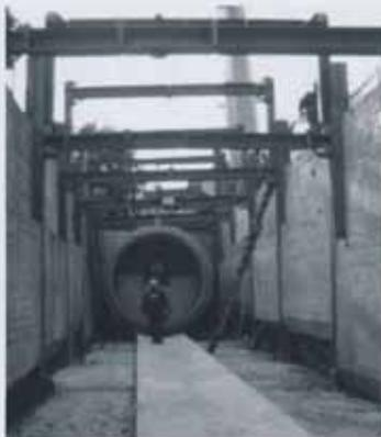
**Bild 3:** Leitungsgraben für Stahlbetonrohrleitung DN 2400 mit normkonformen, relativ schmalen Arbeitsraumbreiten zwischen Verbauelementen und Rohr | Quelle: Emunds & Staudinger
