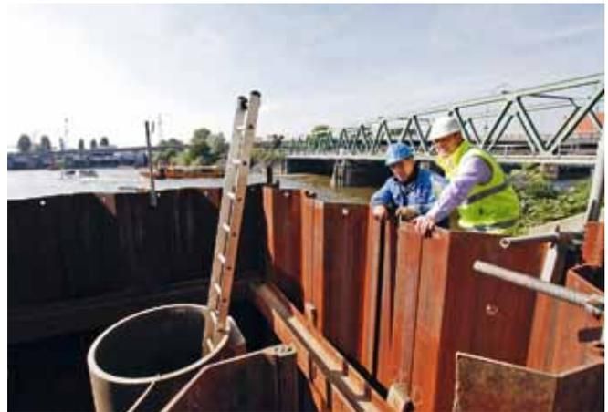
*Dienstleistung im Rahmen der Gütesicherung Kanalbau: Stichprobenartige Kontrolle der Eigenüberwachung und Beratung durch den vom Güteausschuss beauftragten Prüflingenieur.*
