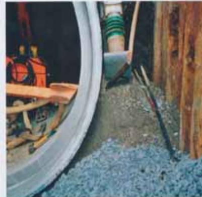
**Bild 2:** Schwierige Arbeitsbedingungen bei Mindestgrabenbreite | Quelle: Güteschutz Kanalbau e.V.
