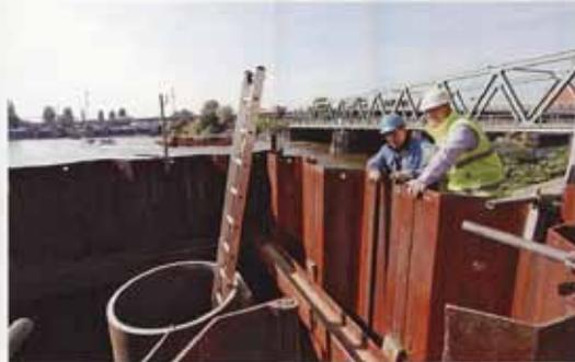
**Bild 4.** Dienstleistung im Rahmen der Gütesicherung Kanalbau: stichprobenartige Kontrolle der Eigenüberwachung und Beratung durch den vom Güteausschuss beauftragten Prüfsingenieur. (Fotos: Güteschutz Kanalbau)
