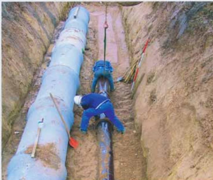
**Bild 4:** Geböschter Leitungsgraben – Einbau von Regenwasser- und Schmutzwasserkanal aus Stahlbeton- bzw. Steinzeugrohren | Quelle: Steinzeug Abwassersysteme GmbH, Frechen
