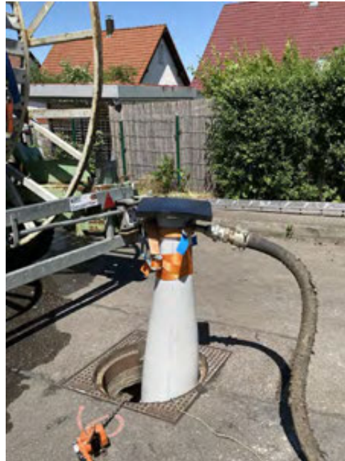
Bild 3: Nachdem beide Rohrenden druckfest verschlossen sind, wird die Haltung mit heißem Dampf beschickt. Druck und Wärme sorgen beim weiteren Arbeitsablauf dafür, dass sich das PE-Rohr durch den Memory-Effekt close-fit an die Innenwandung des alten Rohres legt.
