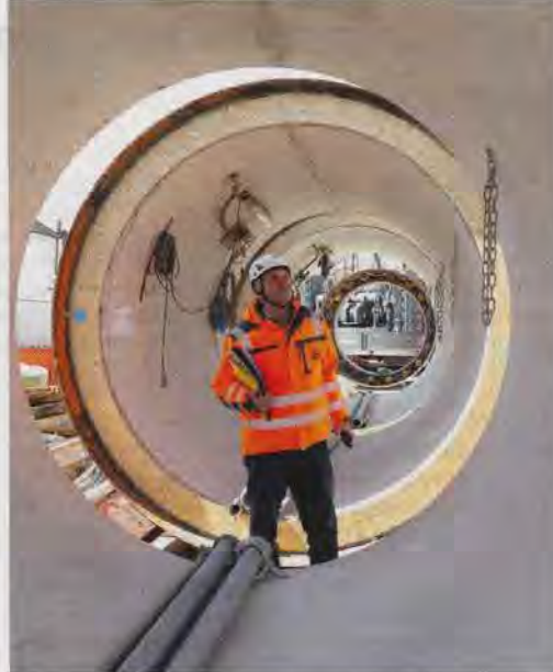
Bild 4: Während einer Baustellenprüfung nimmt Prüflingenieur Dieter Walter, Güteschutz Kanalbau, auch die Vortriebsrohre in Augenschein
