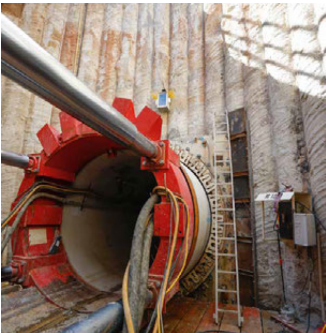
In rund 11 Meter Tiefe finden die Arbeiten zum Bau des Stauraumkanals statt.
