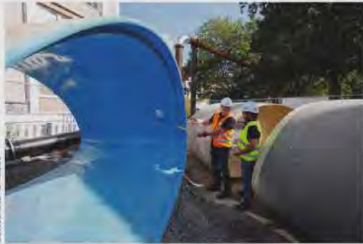
Bild 2: Unterschiedliche Rohrdimensionen; Güteschutz Prüfingenieur Guido Heidbrink (l.) überprüft zusammen mit Aarsleff Oberbauleiter Johannes Leewe die Wandstärke der GFK-Rohre.
