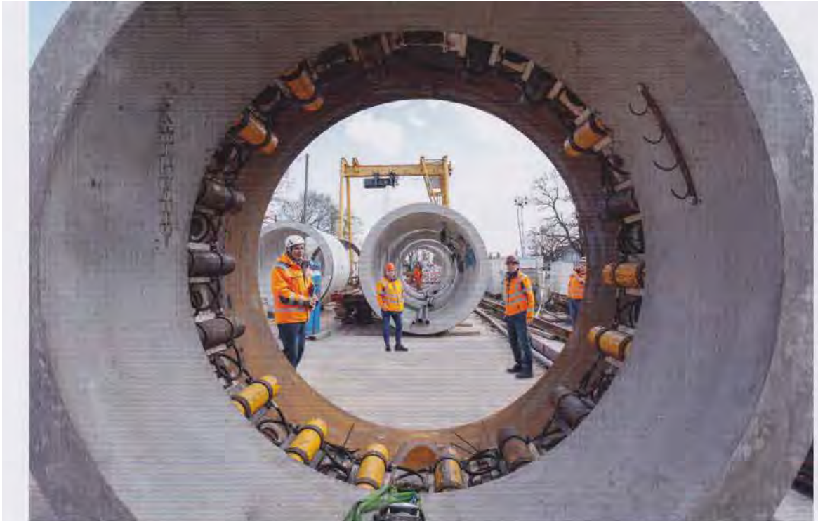
Bei dem zweiten Vortrieb kommen fünf Zwischenpressstationen zum Einsatz. Foto: Güteschutz Kanalbau
