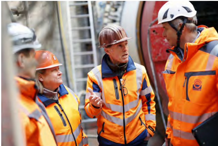
Baubesprechung vor Ort: Reinhard Lang (Mitte) erläutert die aktuellen Vortriebsarbeiten. V.l.n.r.: Christian Trittenbach, Oberbauleiter Sonntag Baugesellschaft mbH & Co. KG, Miriam Liß, Projektleiterin SUN und Dieter Walter
