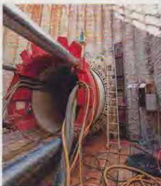
In rund 11 Meter Tiefe finden die Arbeiten zum Bau des Stauraumkanals statt.
