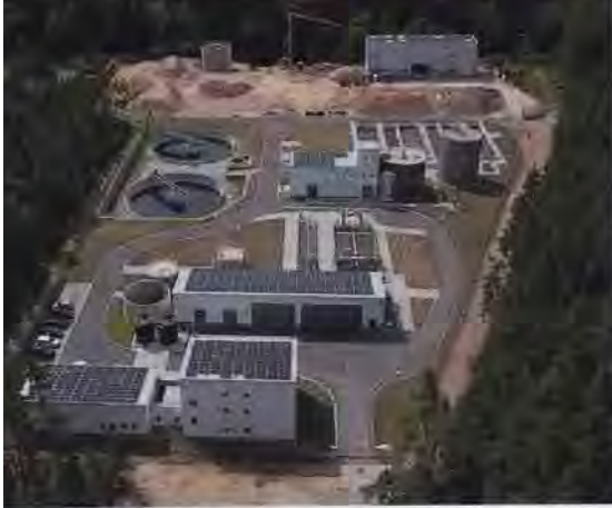
Nach Fertigstellung der Wasserkraftanlage stehen alle drei Säulen zur Stromerzeugung für einen netzdienlichen Betrieb der neuen Kläranlage zur Verfügung.
