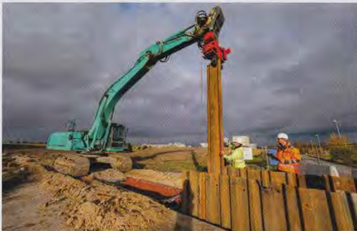
Engagement für Qualität: Die Arbeit der Prüfingenieure auf den Baustellen zur Sicherung der Bauqualität und Arbeitssicherheit wird von den kommunalen Auftraggebern und Netzbetreibern sehr positiv bewertet. Fotos: Güteschutz Kanalbau
