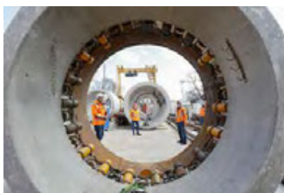
Bei dem zweiten Vortrieb kommen fünf Zwischenpressstationen zum Einsatz. (Foto: Güteschutz Kanalbau)
