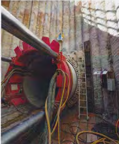
Bild 3: In rund 11 m Tiefe finden die Arbeiten zum Bau des Stauraumkanals statt
