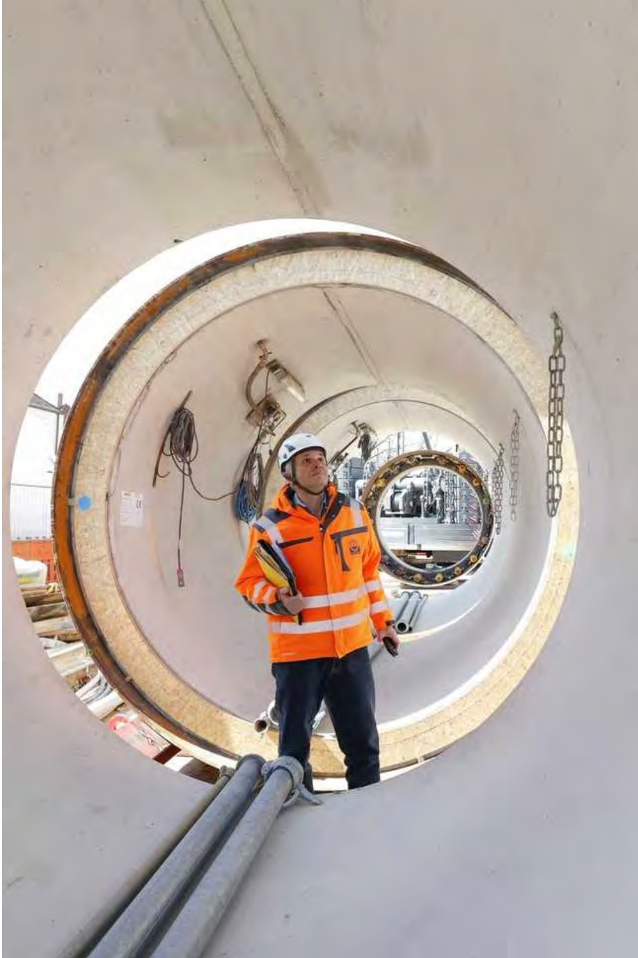
Während einer Baustellenprüfung nimmt Prüfenieur Dieter Walter, Güteschutz Kanalbau, auch die Vortriebsrohre in Augenschein. | Foto: Güteschutz Kanalbau
