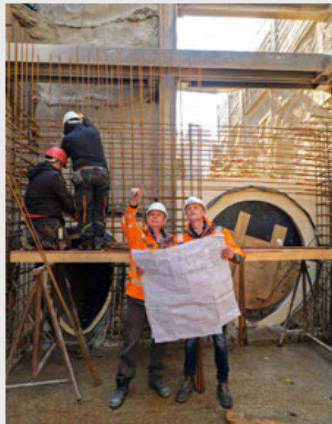
Bild 1: Ein wichtiger Bestandteil der Gütesicherung Kanalbau sind die von den Prüffingenieuren durchgeführten Baustellen- und Firmenprüfungen. Zurzeit überprüfen 28 Prüffingenieure bundesweit sowie im benachbarten Ausland die Qualifikation der Gütezeicheninhaber
