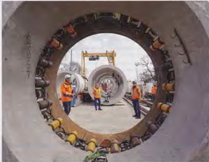
Bei dem zweiten Vortrieb kommen fünf Zwischenpressstationen zum Einsatz. | Fotos: Güteschutz Kanalbau
