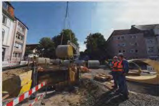
Bild 3: Die GFK-Rohre werden mit einem Kran in die Baugrube abgelassen und von dort mit einem speziellen Fahrzeug in die Lutter-Verrohrung eingefahren. Alexander Garen (Umweltbetrieb der Stadt Bielefeld, rechts) und Prüfingenieur Guido Heidbrink (Güteschutz Kanalbau, links) besprechen den Sanierungsfortschritt.
