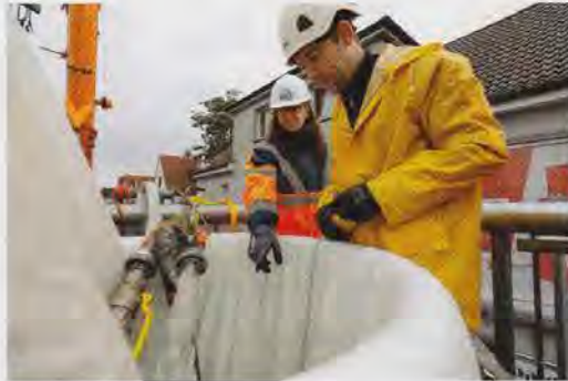
Bild 2. Bei den unangemeldeten Baustellenbesuchen begutachten die Prüferinnen und die die Qualifikation und Zuverlässigkeit der Fachunternehmen. Dabei werden entsprechend den allgemein anerkannten Regeln der Technik die Ausführung der Maßnahme, die personelle und maschinentechnische Ausstattung sowie die Eigenüberwachung geprüft. (Abb./Foto: Güteschutz Kanalbau)
