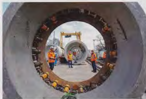
Bild 2: Bei dem zweiten Vortrieb kommen fünf Zwischenpressstationen zum Einsatz.
