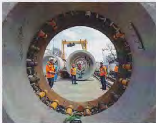
Bild 2: Bei dem zweiten Vortrieb kommen fünf Zwischenpressstationen zum Einsatz
