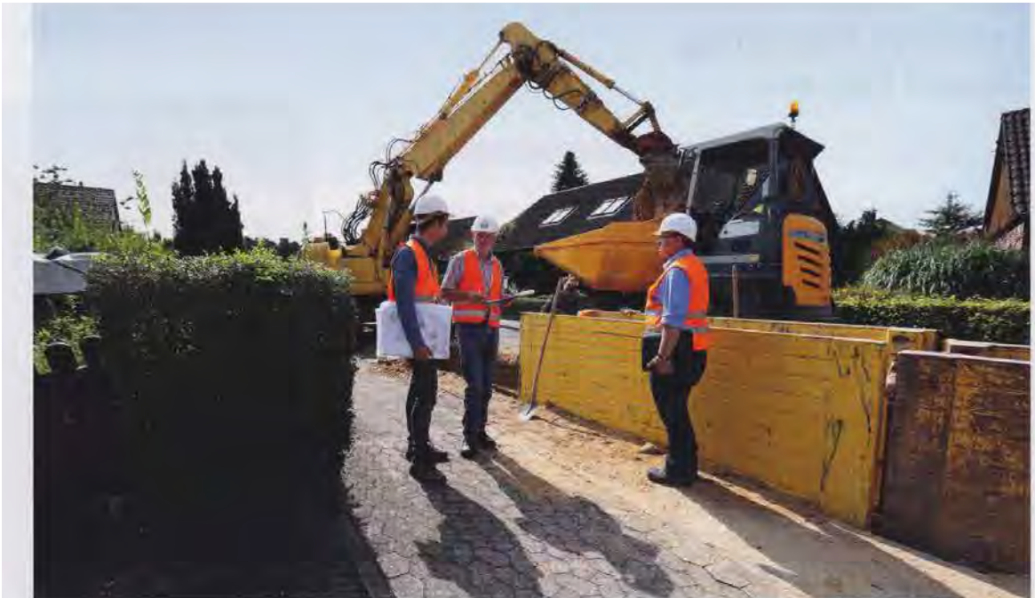
Hohe Ausführungsqualität und damit langfristig wirtschaftliche und nachhaltige Investitionen werden dort erreicht, wo Auftraggeber dies als klare Zielvorstellung formulieren und sich für dieses Ziel einsetzen. Foto: Güteschutz Kanalbau
