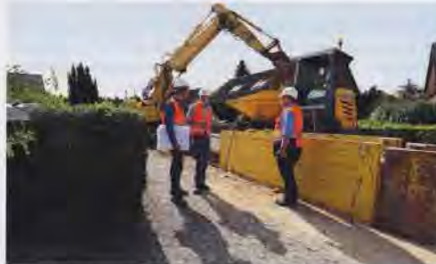
Hohe Ausführungsqualität und damit langfristig wirtschaftliche und nachhaltige Investitionen werden dort erreicht, wo Auftraggeber dies als klare Zielvorstellung formulieren und sich für dieses Ziel einsetzen. Foto: Güteschutz Kanalbau
