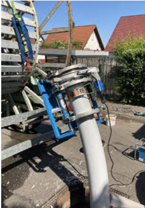
Bild 2: Vorbereitung des PE-Rohrstranges für das Aufschweißen der Dampfplatte.
