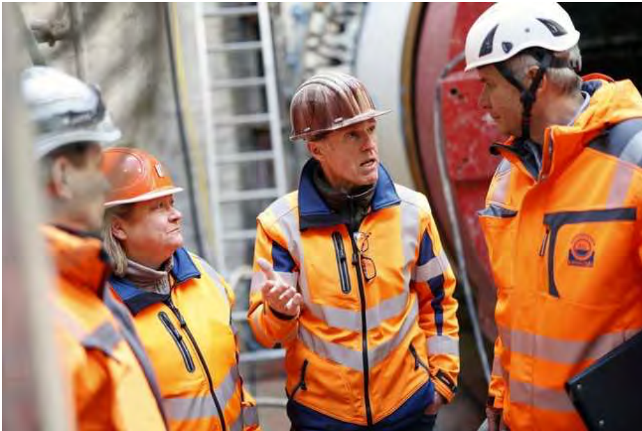
Baubesprechung vor Ort: Reinhard Lang (Mitte) erläutert die aktuellen Vortriebsarbeiten. V.l.n.r.: Oberbauleiter Christian Trittenbach, Projektleiterin Miriam Liß, Prüffingenieur Dieter Walter. | Foto: Güteschutz Kanalbau
