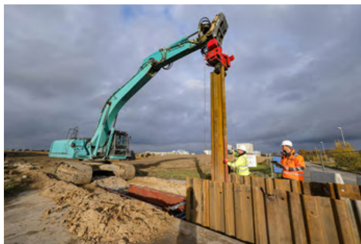
Engagement für Qualität: Die Arbeit der Prüfm Ingenieure auf den Baustellen zur Sicherung der Bauqualität und Arbeitssicherheit wird von den kommunalen Auftraggebern und Netzbetreibern sehr positiv bewertet. Foto: Güteschutz Kanalbau
