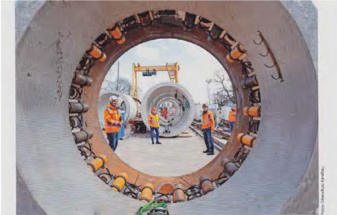
Bei dem zweiten Vortrieb in Nürnberg kommen fünf Zwischenpressstationen zum Einsatz.
