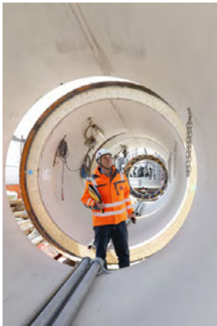
Während einer Baustellenprüfung nimmt Prüfsingenieur Dieter Walter, Güteschutz Kanalbau, auch die Vortriebsrohre in Augenschein
