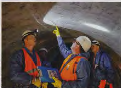
Bild 4: Risse im Scheitelbereich der Lutter-Verrohrung gehörten zum Schadensbild. V. l. n. r.: Alexander Garen (Umweltbetrieb der Stadt Bielefeld), Johannes Leewe (Aarsleff Rohrsanierung), Guido Heidbrink (Güteschutz Kanalbau) und Klaus Schultz (Umweltbetrieb der Stadt Bielefeld).
