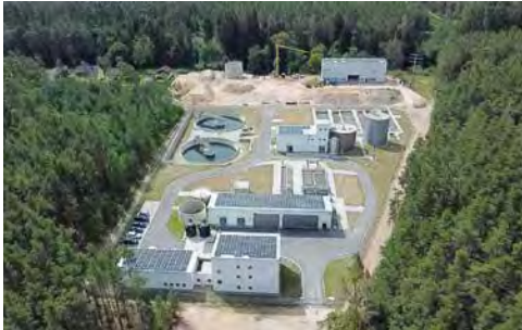
Bild 2 Nach Fertigstellung der Wasserkraftanlage stehen alle drei Säulen zur Stromerzeugung für einen netzdienlichen Betrieb der neuen Kläranlage zur Verfügung. Quelle: KZV „Schwarzachgruppe“
