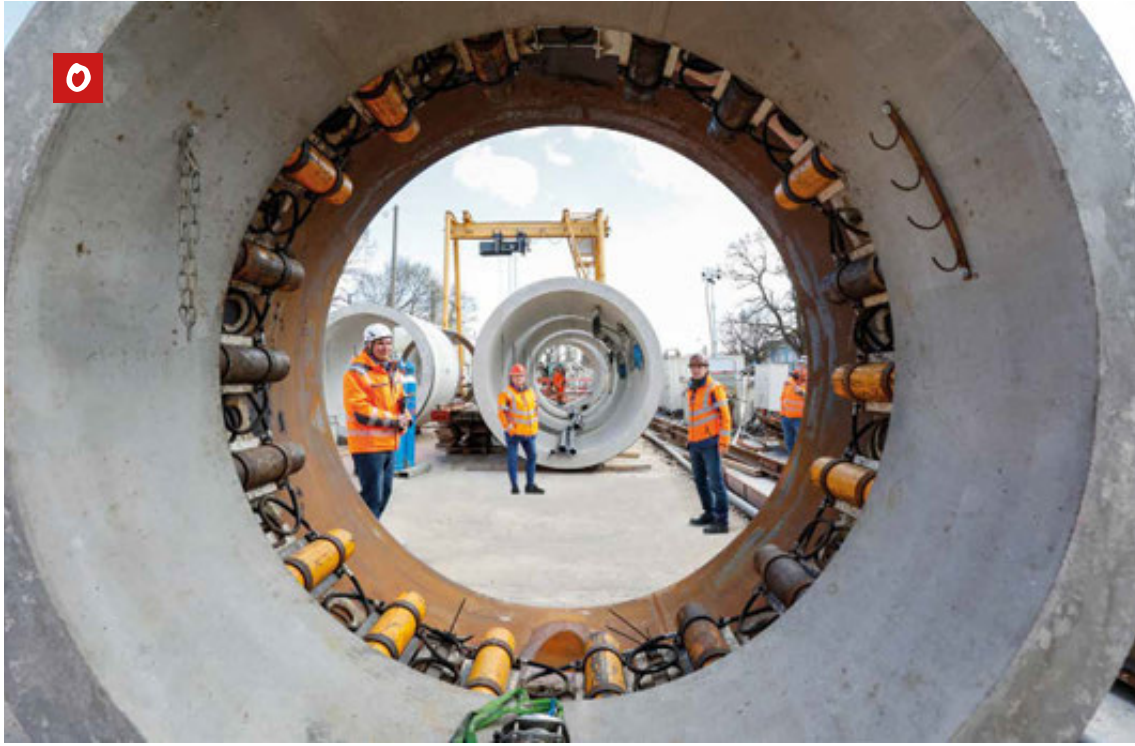
Bild 1: Beim zweiten Vortrieb werden fünf Zwischen- pressstationen eingesetzt. © Güteschutz Kanalbau
