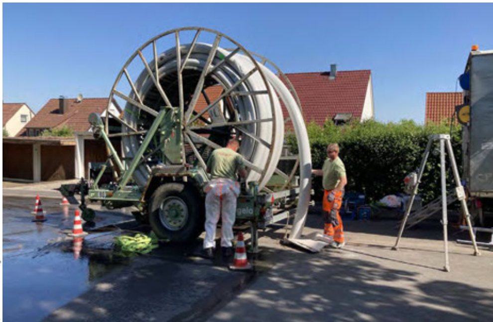
Bild 1: Beim Compact Pipe-Verfahren werden Standard-PE-Rohre gefaltet und aufgetrommelt zur Baustelle geliefert.
