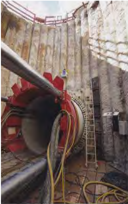
In rund 11 Meter Tiefe finden die Arbeiten zum Bau des Stauraumkanals statt.
