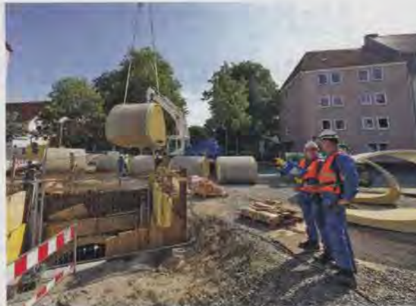
Die GFK-Rohre werden mit einem Kran in die Baugrube abgelassen und von dort mit einem speziellen Fahrwagen in die Lutter-Verrohrung eingefahren.
