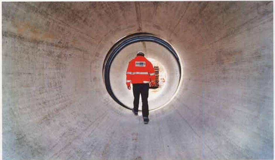
Zur Gütesicherung gehört auch eine Sichtprüfung der 4 m langen FBS-Stahlbetonrohre DN 2.500 vor dem Einbau der Rohre. | Foto: Brochier Spezialtiefbau GmbH
