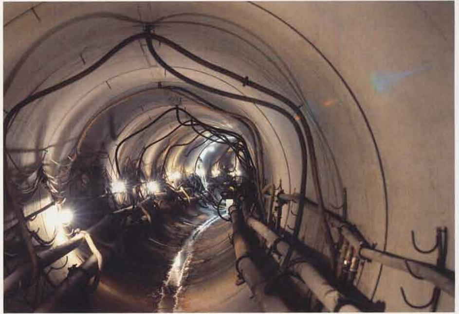
Blick in den bereits eingebauten Rohrstrang - der Stauraumkanal wurde mit einer doppelten Kurvenfahrt (Radius je 500 m) eingebaut. | Foto: Brochier Spezialtiefbau GmbH
