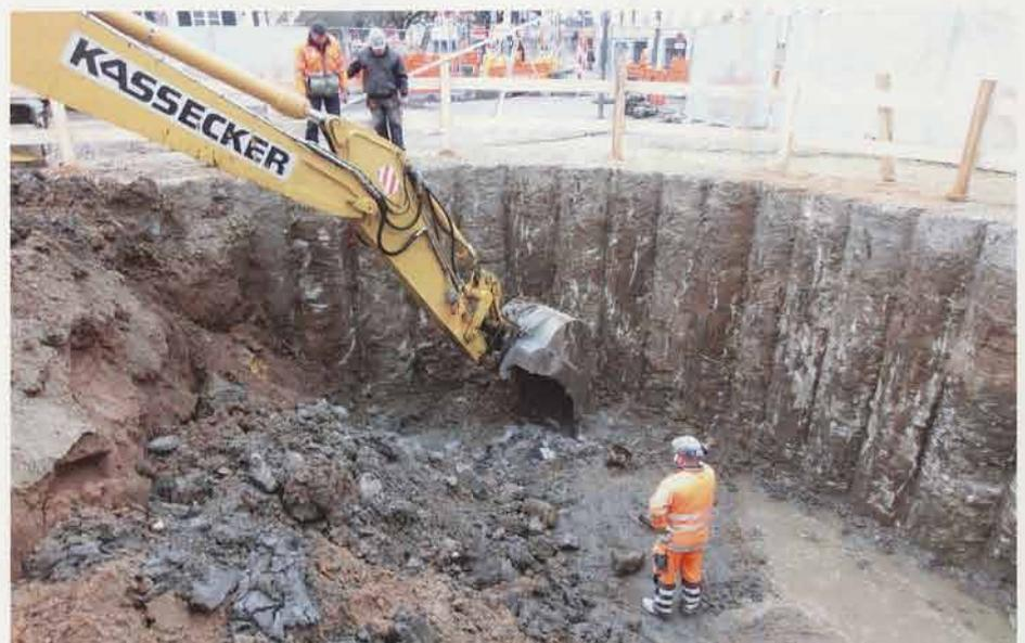
Insgesamt wurden sieben Baugruben für die Vortriebsmaßnahme mit Flächen zwischen 50 und 400 m<sup>2</sup> erstellt. Die Baugruben wurden mit überschnittenen Bohrpfahlwänden gesichert. | Foto: Franz Kassecker GmbH
